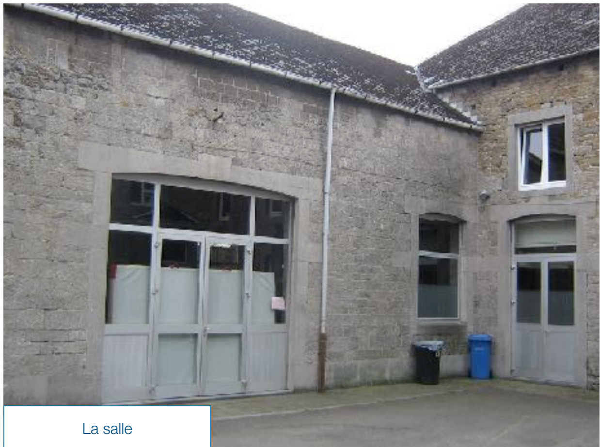
Accès vers la salle
